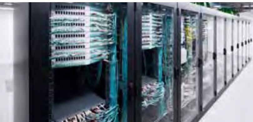
Rechenzentrum der Aareon AG, Mainz
